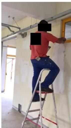
Figura 1 – Preparação da superfície (Emassamento)
