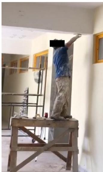
Figura 2 – Preparação da superfície (Lixamento)
