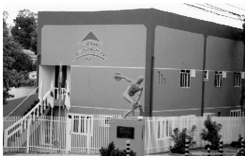
Casa da Educação Física - FIEP em Foz do Iguaçu/PR
